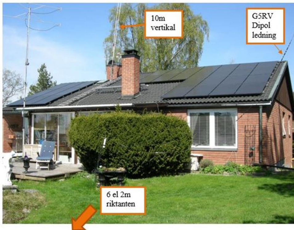
Figur 19: Antennerna är monterade omedelbart intill solcellsanläggningen.
