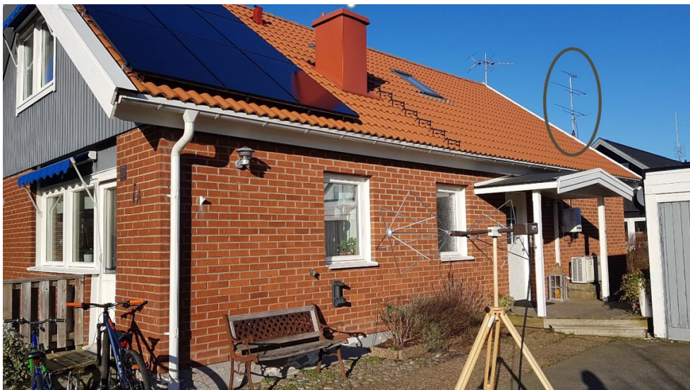
Figur 25: Solceller med optimerare på vardera sidan om hustaket.
