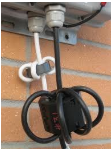
Figur 17: Ferriter på kablar.
